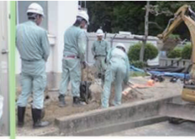
土木・水道工事
