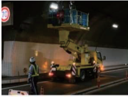
高速道路 維持・管理工事
